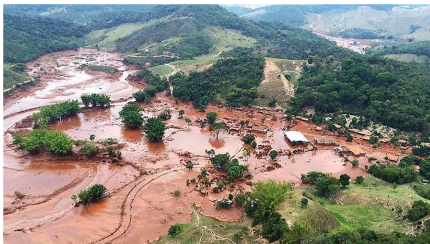
Figura 4 – Imagem aérea de Bento Rodrigues após o rompimento da barragem do Fundão
